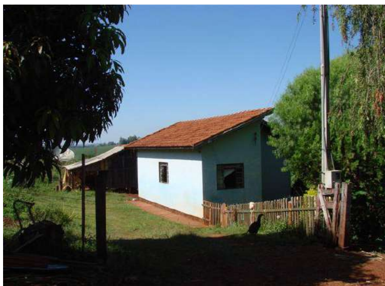
Figura 31 – Foto – Tipologia de Residência na Vila Rural
